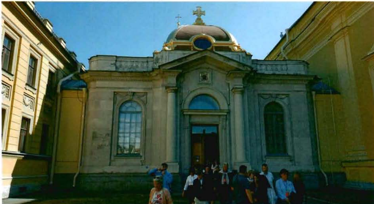
1. Фасад царского подъезда. Вид с запада.
